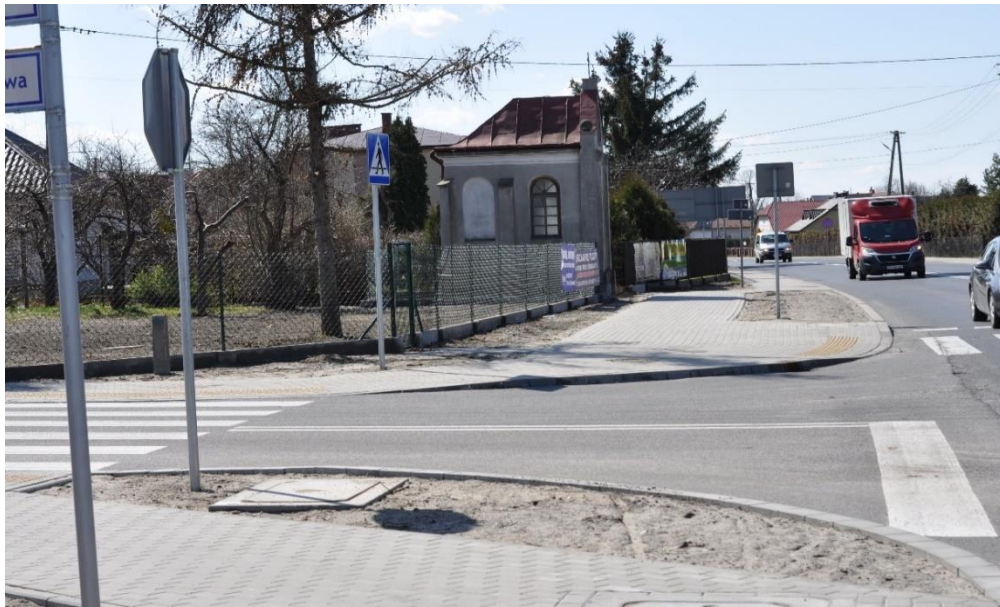
Przebudowana ulica Jagiellońska , przesunięta Kaplica
