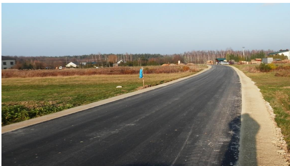
Droga gminna nr 104096R „Komorów – Brzostowa Góra
