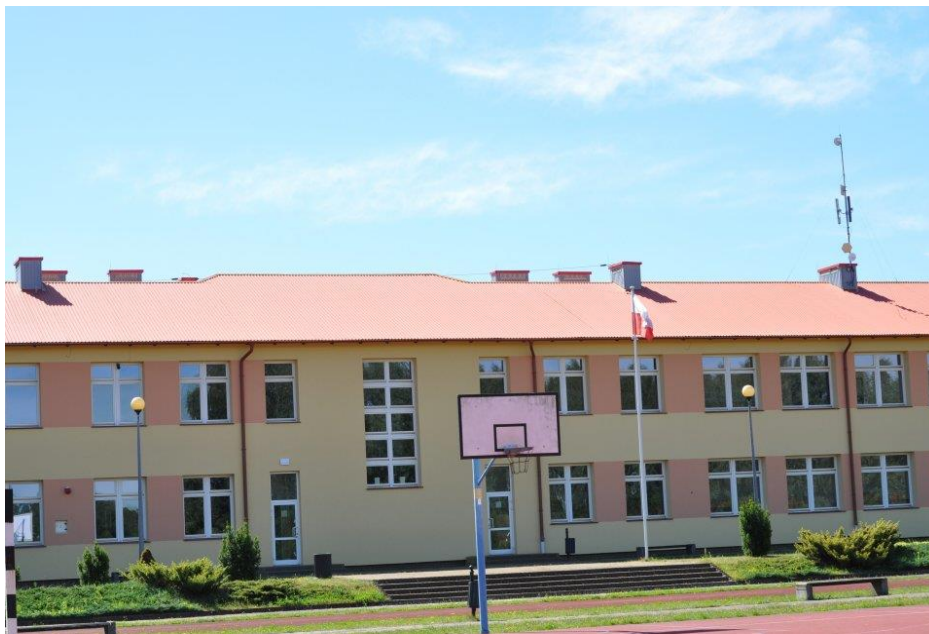
Odnowiona elewacja na budynku PSP Majdan Królewski os. Podlasek
