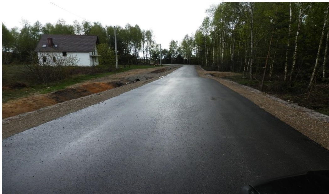
Droga gminna „Do Tęczy” w Krzątce
