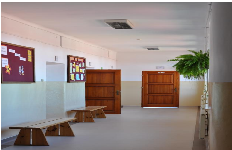
Nowa nawierzchnia korytarzy w PSP Huta Komorowska
