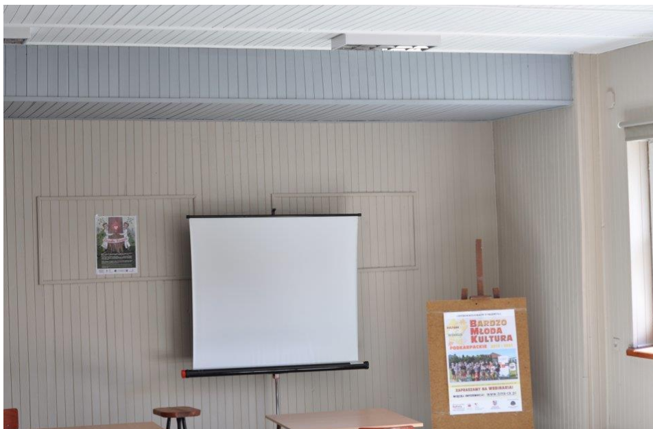
Odnowiona świetlica w PSP Komorów
