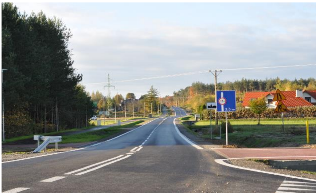
Droga powiatowej Nr 1162 R w miejscowości Komorów
