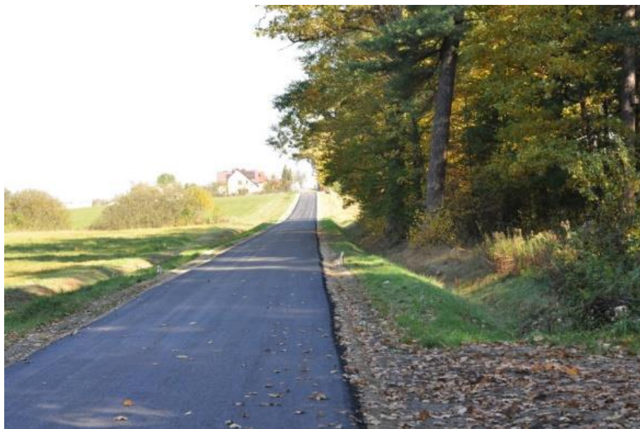
Droga „Rozkopana” Brzostowa Góra – Poręby Dymarskie
