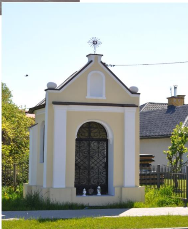
Odremontowana w 2022r Kaplica Chrystusa Ukrzyżowanego przy drodze krajowej nr 9 w Majdanie Królewski
