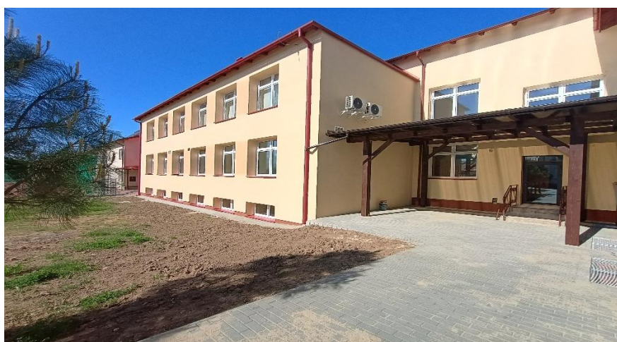
Przebudowana część budynku PSP z przeznaczeniem na żłobek
